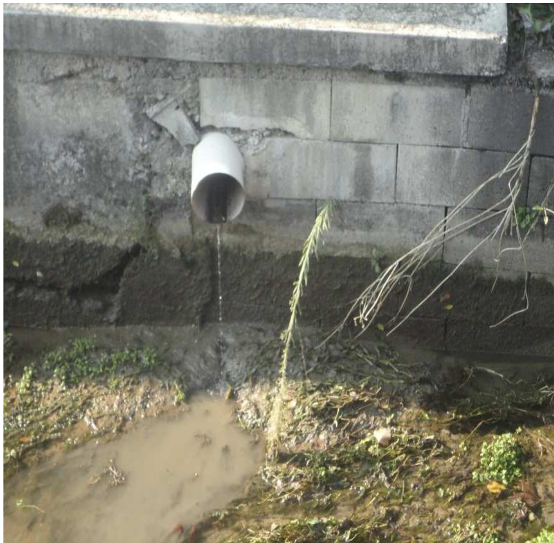
Figura 2 particolare uscita condotto acque meteoriche nella Roggia
