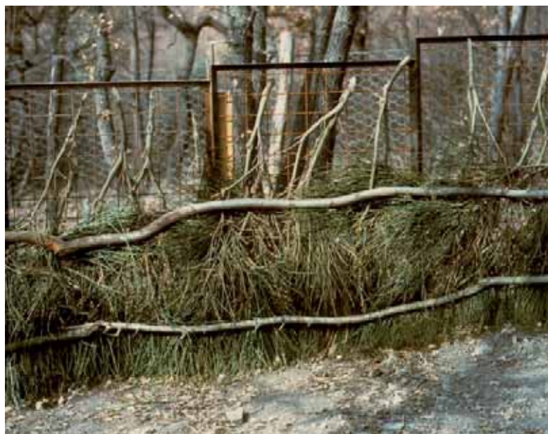
Figura 4 – Rivestimento del chiusino con fascine di ginestra.
