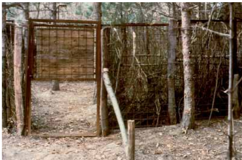
Figura 5 – Ancoraggio dei pannelli agli alberi circostanti.
