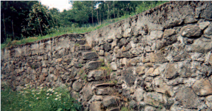
Scala di collegamento tra terrazzi
