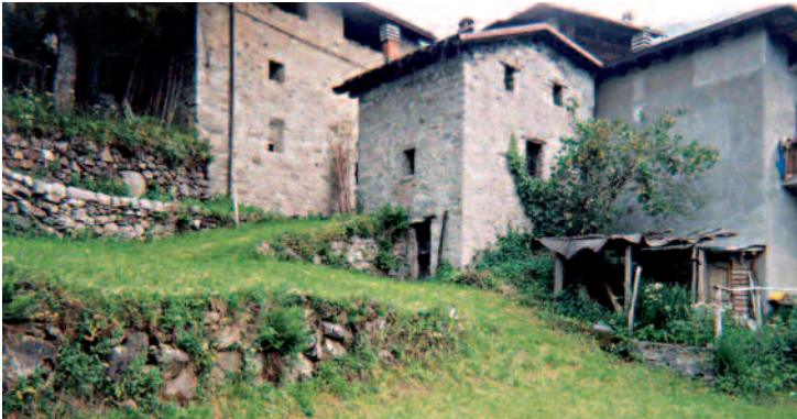
Rampe di collegamento tra terrazzi
