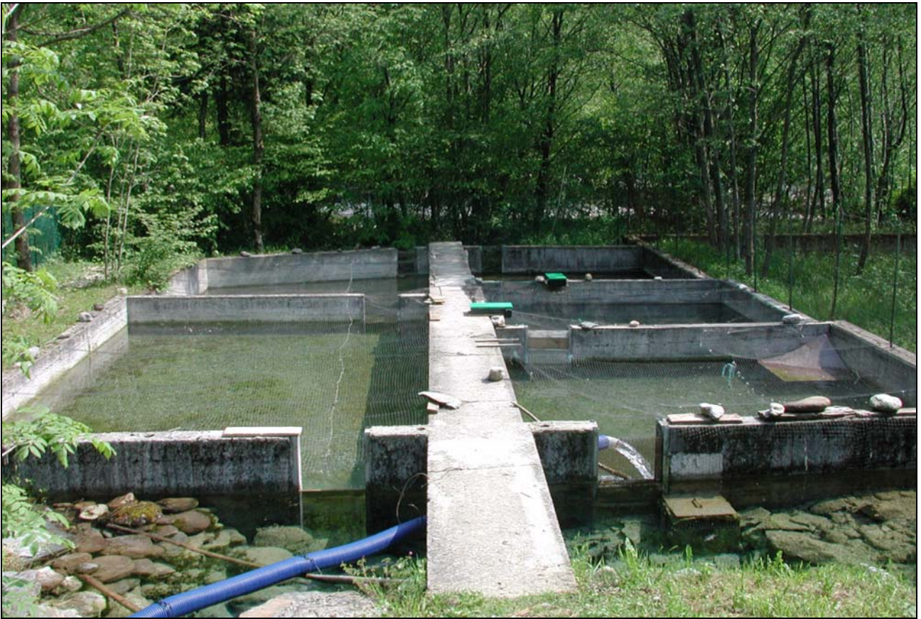
Figura 20: vasche esterne in cemento
