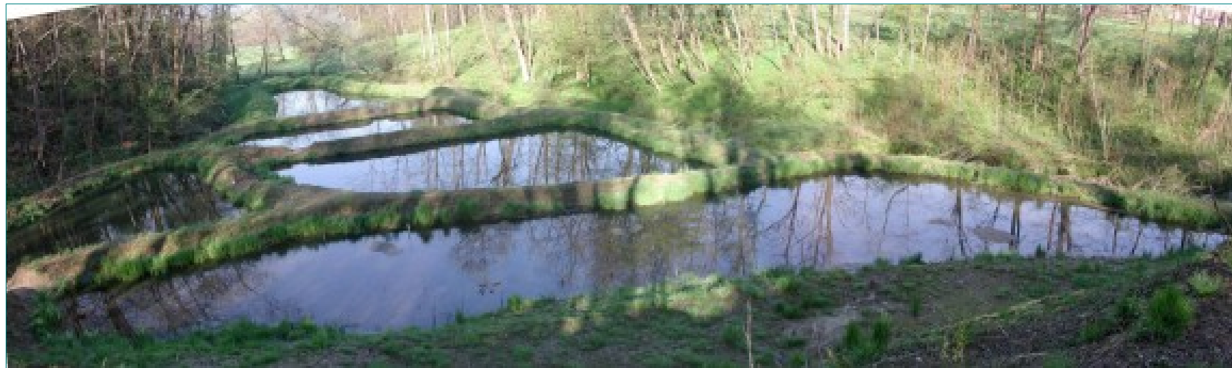
Foto 1: impianto di affinamento dell'impianto convenzionale di Cadrezzate (VA) – Sistema integrato fitodepurazione – lagunaggio
